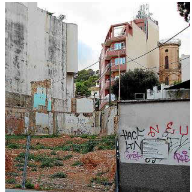
An dem Carrer Bellver wurde ein historisches Gebäude für ein neues Wohnungsprojekt dem Erdboden gleichgemacht.
