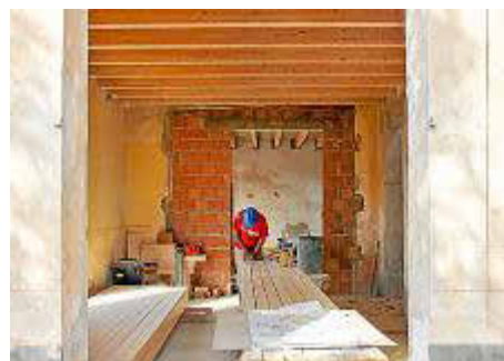
Sämtliche Dachbalken des historischen Gebäudes wurden ausgetauscht.
