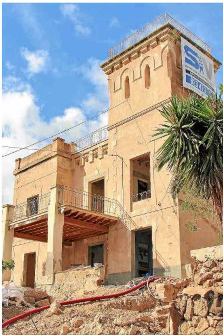
Seit Juni läuft die Sanierung der Prachtvilla. In anderthalb bis zwei Jahren soll das Herrenhaus in neuem Glanz erstrahlen. Fotos: M. Schulte
